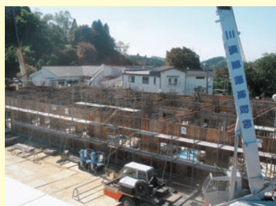
H19.10 南棟基礎工事が着々と
