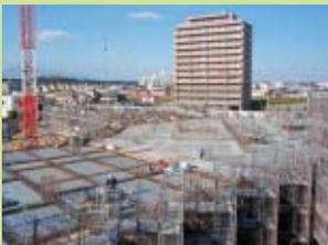
11/4 2F床配筋・コンクリート工事
