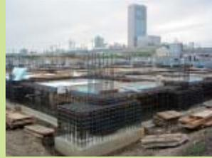
7/23 基礎鉄筋・型枠工事
