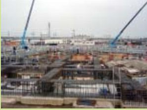
7/23 基礎鉄筋・型枠工事
