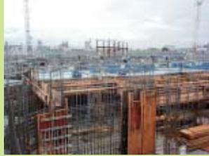
10/6 2F梁床配筋・床型枠工事
