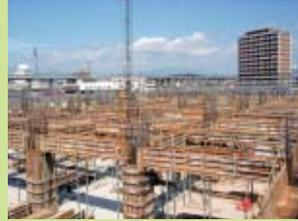
9/10 1F柱配筋・梁型枠工事
