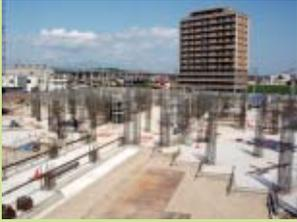
9/10 1F柱・壁配筋工事
