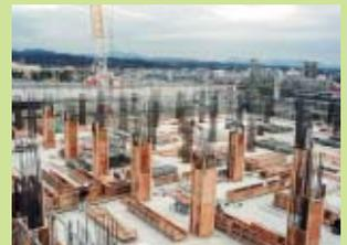
12/7 3F柱配筋・型枠工事
