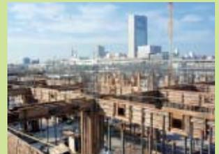
11/4 2F柱・3F梁型枠工事
