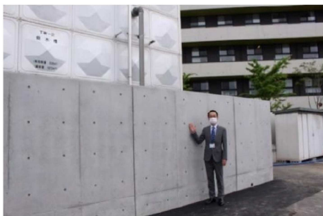
写真5 コンクリート擁壁
