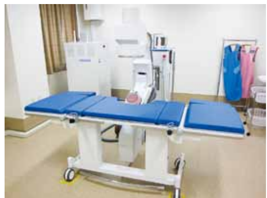
音波の一種である衝撃波を体の外から結石に向けて照射し、筋肉や他の臓器を傷つけることなく、結石のみを細かく破砕する「結石破砕装置」。
