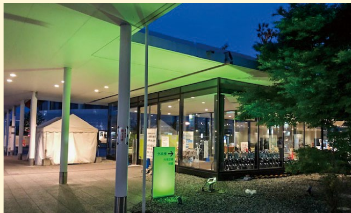
病院入口のライトアップ
