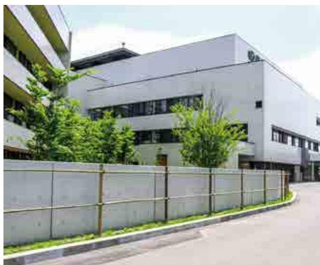
③コンクリート防水壁（病棟～救急入口）
