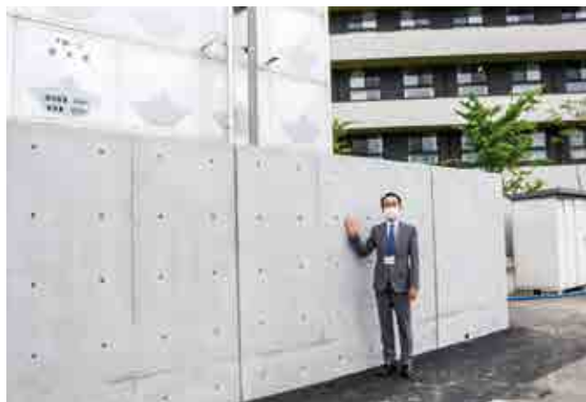
重要なインフラ設備を守る 遮水壁
