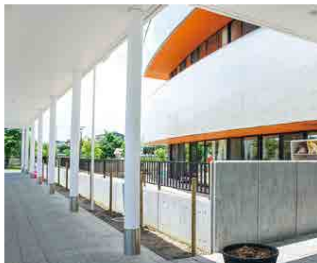
⑥コンクリート防水壁（リハビリ・保育施設）
